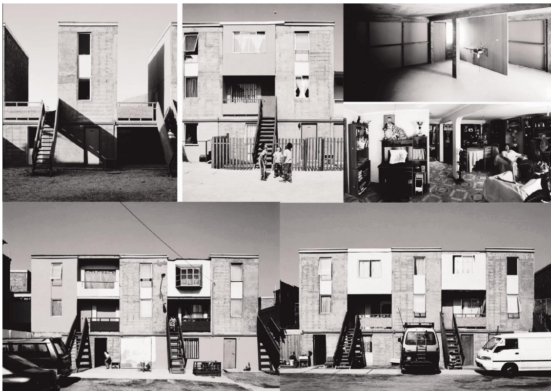
Figura 4. Fotografías de las viviendas adaptadas
